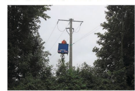
La circulation a été ralentie sur la RN 13 pour permettre à Enedis de déposer trois lignes électriques aériennes. (Photo : Guillaume)
