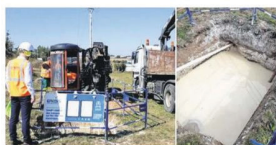
Un forage de 170 mètres a permis de passer deux câbles électriques sous le périphérique de Caen. Ici, la foreuse sous la ligne aérienne 20 000 volts et, à droite, l'emplacement du forage à Fleury.
