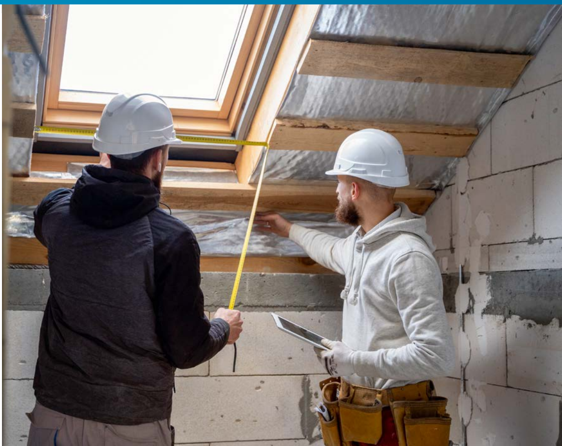
La rénovation énergétique des bâtiments publics locaux entre dans les aides du Fonds vert.
